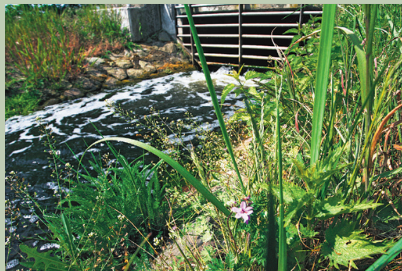
Klares Wasser aus dem Auslauf einer Kläranlage. Die Anforderungen an das gereinigte Abwasser aus großen Kläranlagen sind viel höher als für biologische Kleinkläranlagen.
