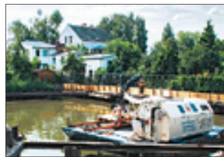
So sah es zeitweise während der Bauphase in der Sembritzkistraße aus.
