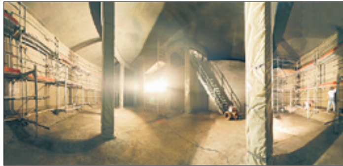
Bauscheinwerfer beleuchten die Endphase der Innensanierung. Schon bald schaltet die Ampel zur Inbetriebnahme des ersten Hochbehälters auf Grün.
