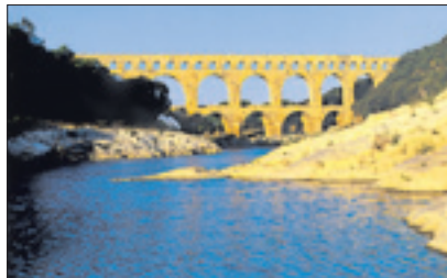
Der zwischen 40 und 60 n. Chr. errichtete 50 m hohe Pont du Gard bei Nîmes ist wohl das bekannteste Brückenquädukt der Römer. 40.000 m 3 Wasser wurden hier täglich nach Nîmes transportiert.
