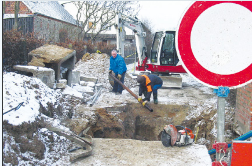
Nach dem Beginn der Frostperiode Ende November war auch mit starker Technik dem knüppelhaften Boden nicht mehr beizukommen.
