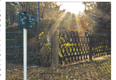
Die Schilder lassen es vermuten: Leitungen queren Privatgelände.
