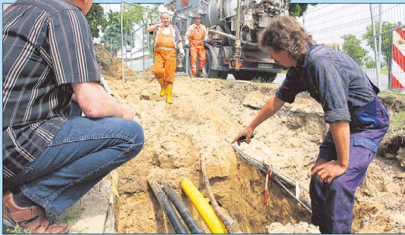
Jörg Kampioni (r.), Vorarbeiter der in Rauen tätigen Baufirma SK Kesslau, erklärt an der „Startgrube“ den unterirdischen Vortrieb.
