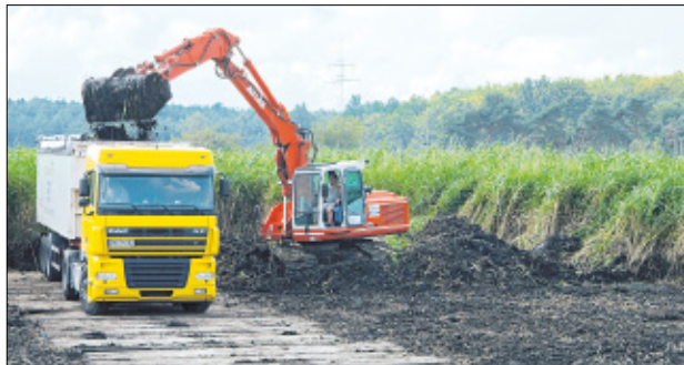
Nach jeweils etwa acht Jahren werden die Beete zur Verwertung der Klärschlammdecker bearbeitet.
