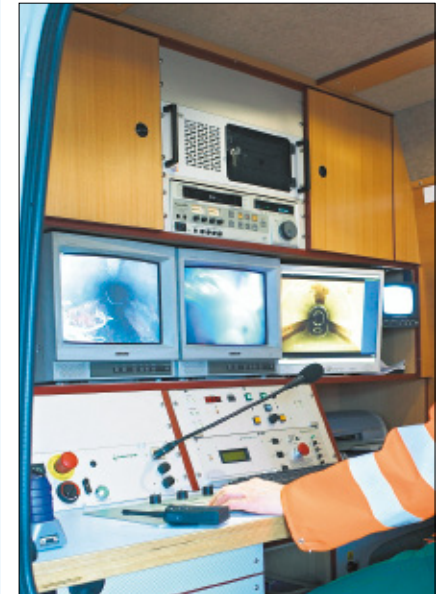
Fingerspitzengefühl, geübtes Auge, profundes Wissen – damit steuert der „Kanal-TV-Regisseur“ seine Kamera durchs Labyrinth.
