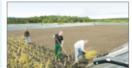
Vorfristig zur Pflanzung fertig – die Vererdungsbeete der Kläranlage.
