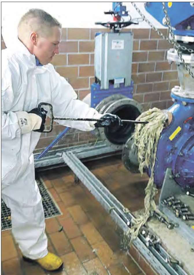
Sebastian Wollank beseitigt (wieder einmal) Verstopfungen durch Verzapfungen – hier am Regenüberlaufbecken.
