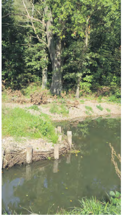
Totholzbuhrnen schützen das Ufer und fördern die Eigenentwicklung der Dahme in diesem Bereich nachhaltig. Der Altarmanschluss verbindet Fluss und Aue und schafft zusätzlich Lebensräume.
