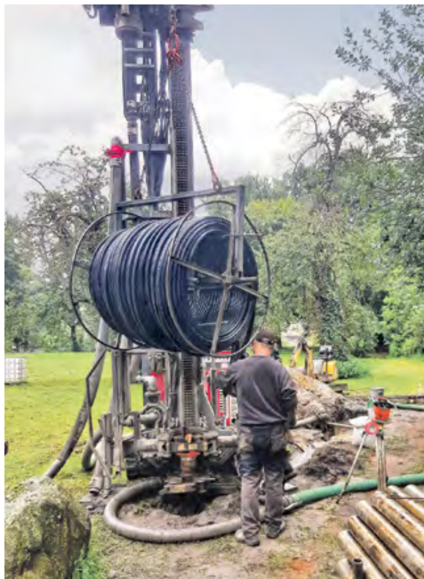
Probebohrung: 80 Meter tief sollen die Sonden für die Geothermieranlage reichen. Vor dem Bau wurde der Untergrund erkundet.
