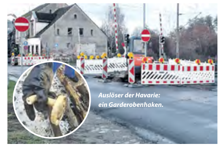
Baustelle: An den Bahngleisen mussten Baugruben ausgehoben werden, der Verkehr wurde dadurch erheblich behindert.
