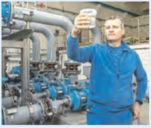
Zählerwechsel: Tom Schnepfel (l.) und Azubi Karl-Wilhelm Stähr tauschen einen Wasserzähler. Das ist alle sechs Jahre Pflicht – dann läuft die gesetzliche Eichfrist aus.
