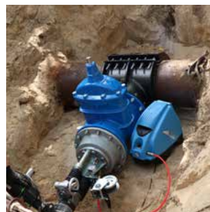
Austausch: Die neue Leitung wurde an eine größere, in Betrieb befindliche Leitung angeschlossen. Diese Anbindung erforderte eine besondere Anbohrtechnik.
