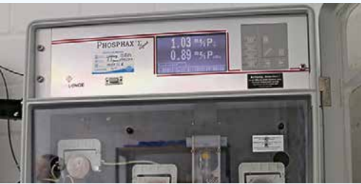
Messstelle: Bevor das aufbereitete Abwasser in die Spree fließen darf, wird es noch einmal kontrolliert. So muss zum Beispiel ein bestimmter Wert für Phosphor eingehalten werden.
