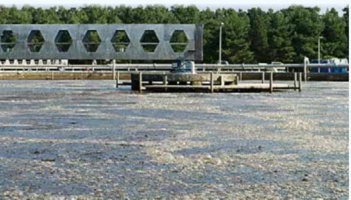
Belebungsbecken: Hier wird zeitweise Sauerstoff eingeblasen. Bakterien bauen schädliche Stoffe ab, unter anderem Stickstoffverbindungen.
