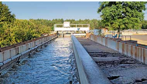
Kombinierter Sand- und Fettfang: Die dicke dunkle Schicht auf dem Wasser besteht aus Fettstoffen und Schmutz, darunter setzt sich am Beckenboden der Sand ab. Bevor das Wasser bakteriell aufbereitet wird, müssen Fett und Sand entfernt und entsorgt werden.
