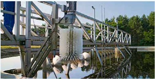
Nachklären: Auf das Belebungs- folgt das Nachklärbecken. Der Klärschlamm setzt sich dort am Grund ab, das gereinigte Wasser kann Richtung Spree geleitet werden.
