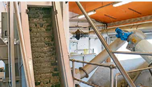
Rechenanlage: Müll und grober Schmutz werden aus dem Wasser gefiltert. Ein großes Problem sind Feuchttücher – sie verstopfen vor allem die Pumpen im Kanalnetz.
