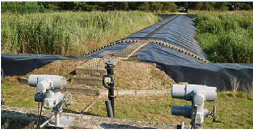
Nachspeicher: Was aussieht wie eine Wiese mit Schilf sind Nachspeicherbecken. Sie dienen als Puffer bei einer Störung oder nach Starkregen.
