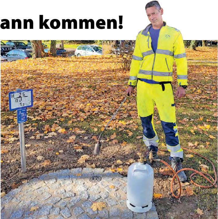
Auf den Notfall vorbereitet: Mit einem Propanbrenner kann Mitarbeiter Daniel Senzky festgefrorene Schieberkappen vom Eis befreien.
