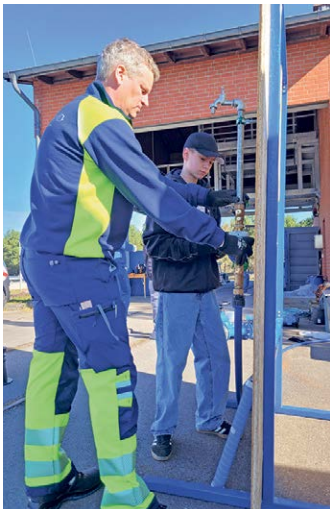
Ausbilder Johannes darf nur festhalten: Niklas schraubt den Wasserzähler in die Armatur.
