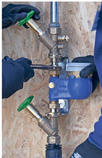
Ausbilder Johannes darf nur festhalten: Niklas schraubt den Wasserzähler in die Armatur.
