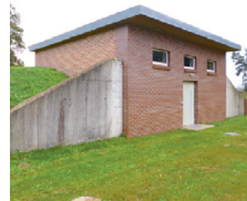
Reinwasserkammern im Wasserwerk Lebus.
