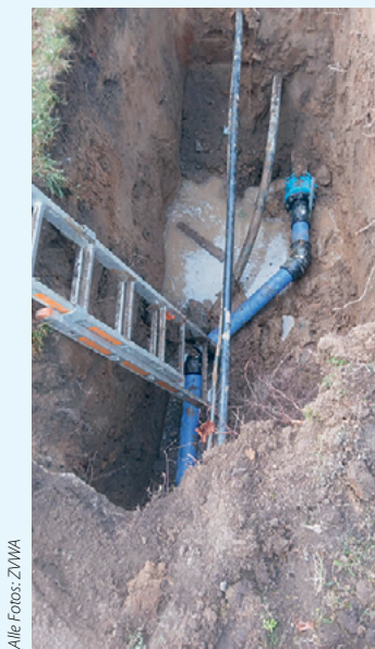
Schacht für den neu verlegten Abschnitt der Versorgungsleitung.
